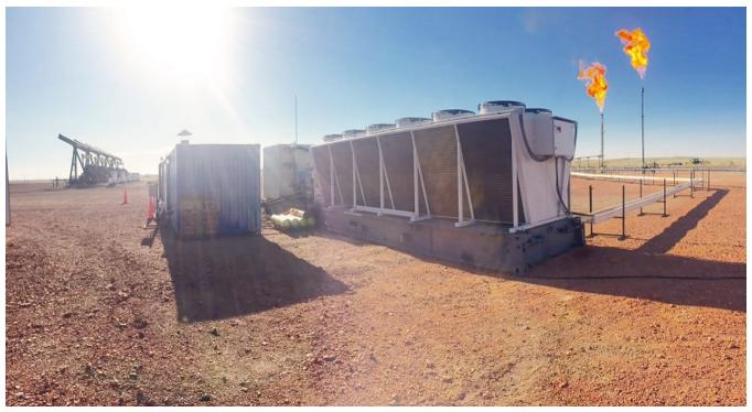
ElectraTherm公司的余热发电技术减少了Hess油井的火炬
