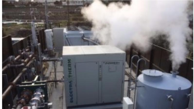
ElectraTherm公司利用有机朗肯循环（ORC）和其专有技术，从77-122°C的低温水中产生高达110kWe的电力。在这个站场，温泉以大约110°C的温度提供不同流量的地热蒸汽。与其他可再生能源不同，地热是基础负荷，可提供持续的热水流，并具有24/7的发电能力。地热热水可用于产生高压蒸汽，通过ElectraTherm专利的双螺杆膨胀机进行膨胀，驱动发电机以产生清洁电力，同时将水冷却至20°C。
